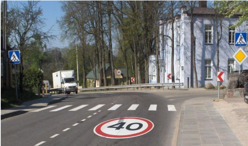
4.12 pav. Priklijuojamo kelio ženklo įrengimas.
