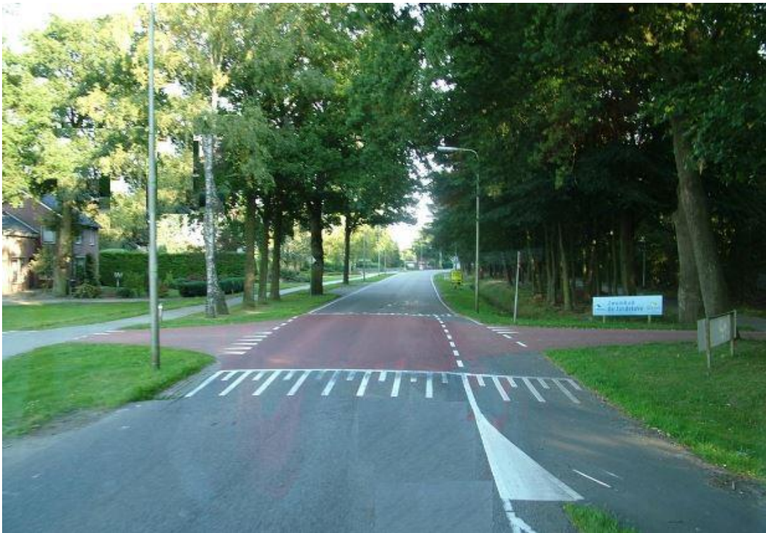
4.5 pav. Iškilios sankryžos įrengimas.
