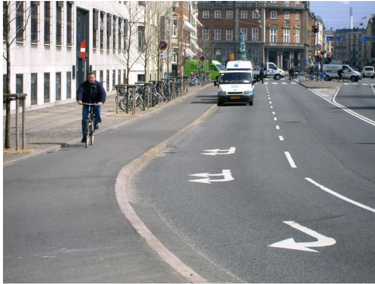
2.12 pav. Dviračių juosta atskirta bortu ir pakelta virš transporto priemonių važiuojamosios dalies.
