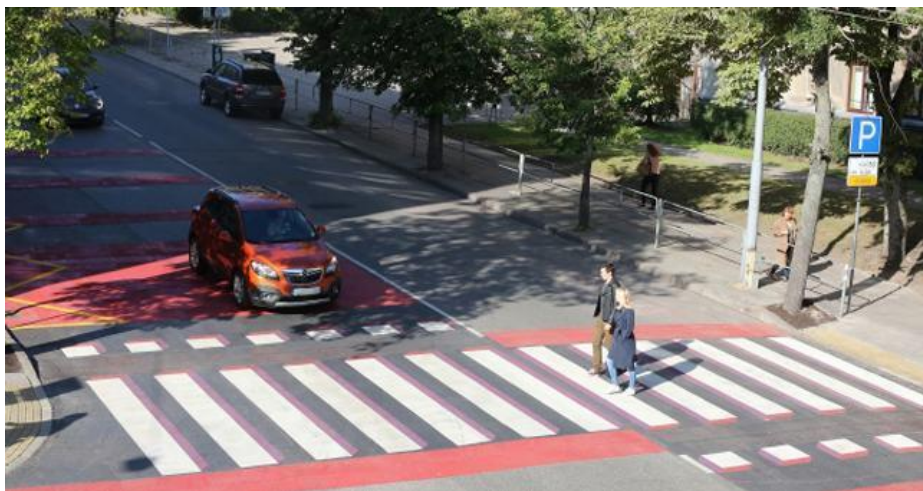
4.15 pav. Trimatis pėsčiųjų perėjos įrengimas (Lietuva).
