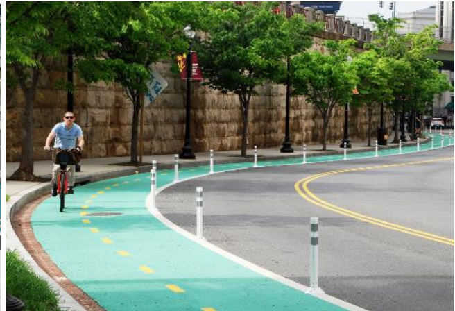
2.13 pav. Dviračių eismo juosta atskirta fiziniais barjeriais.
