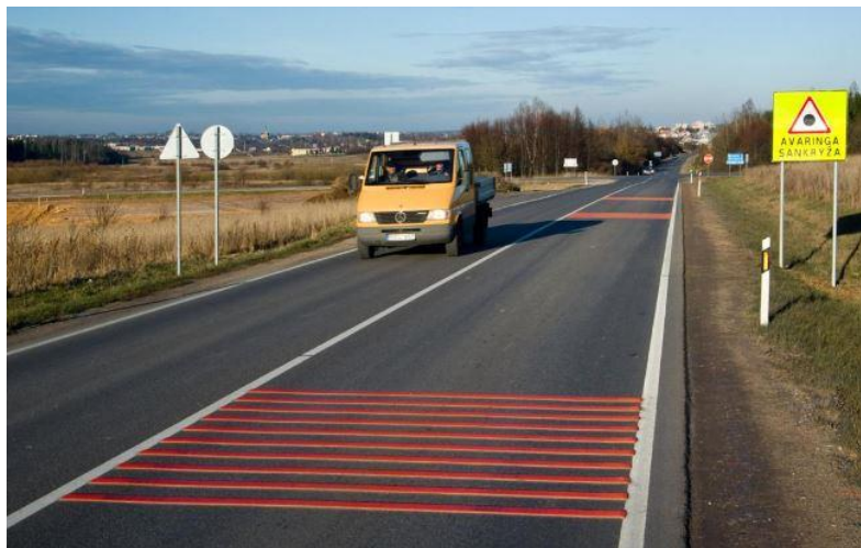
4.6 pav. Iškilųjų skersinių linijų įrengimas.
