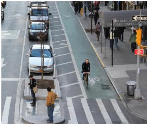
2.14 pav. Dviračių eismo juosta atskirta saugos juosta ir transporto priemonių parkavimu.
