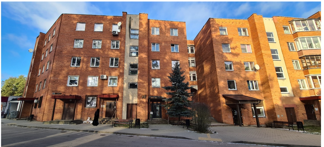
4 pav. Pastato fasadas iš kiemo pusės.
