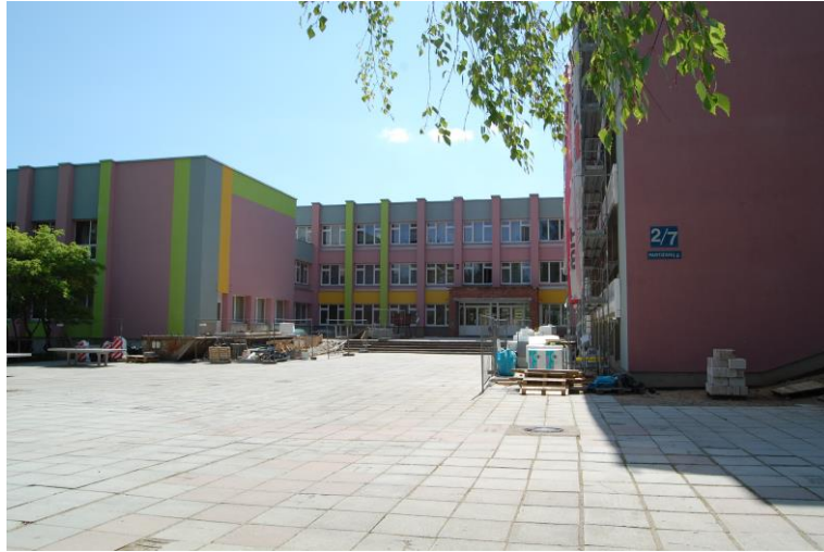
52 pav. Visagino „Gerosios vilties“ progimnazijos apšiltinimo darbai
