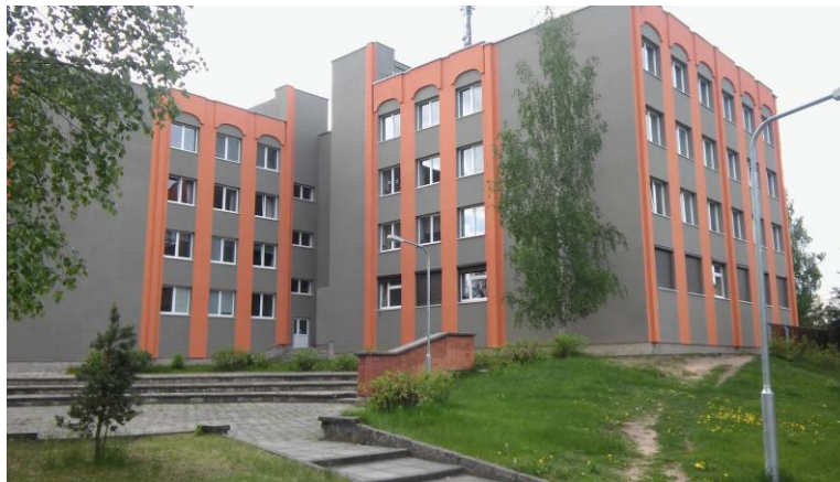
53 pav. Visagino Draugystės progimnazijos apšiltinimo darbai
