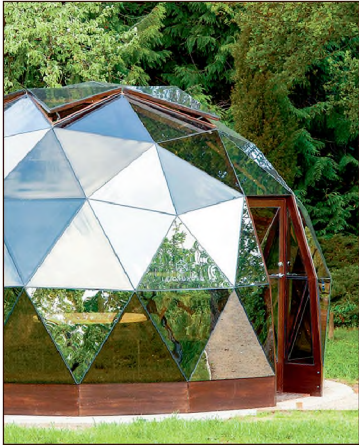
В ноябре 2023 года состоялась торжественная сдача в эксплуатацию реконструированной аллеи Седулинос. Однако после завершения работ висагинцы не увидели на ней трех геокуполов.
