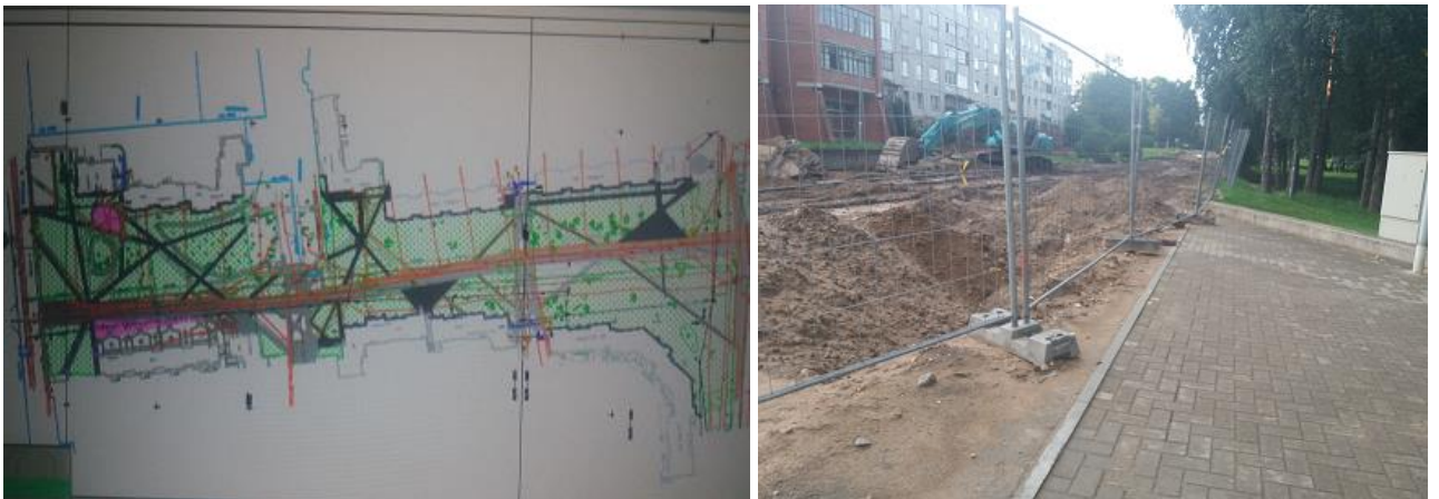
29 pav. Visagino gatvės rekonstrukcijos darbai
