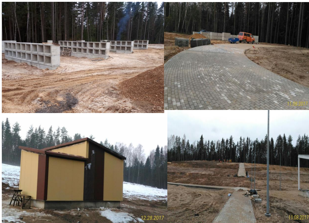
35 pav. Naujų kapinių įrengimo darbų vykdymas
