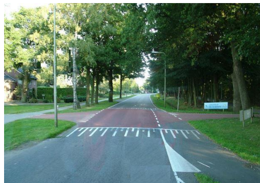
69 pav. Iškilios sankryžos įrengimas.
