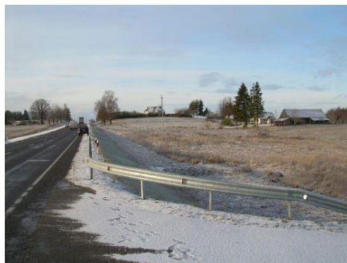
79 pav. Apsauginio atitvaro įrengimas.
