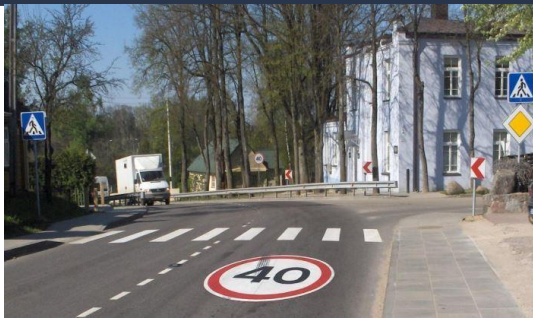
75 pav. Priklijuojamo kelio ženklo įrengimas.
