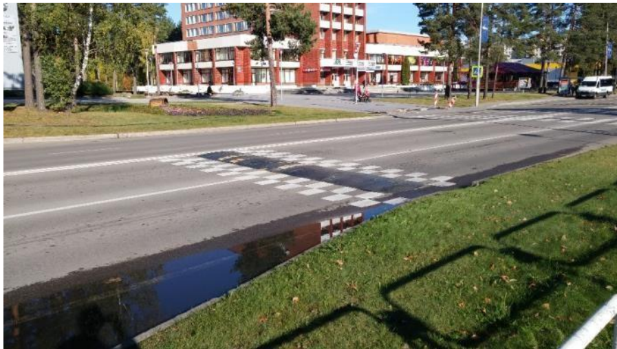
47 pav. Greičio ribojimo kalneliai
