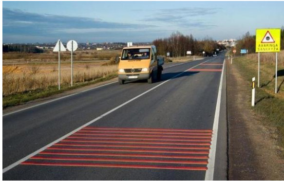
70 pav. Iškilųjų skersinių linijų įrengimas.
