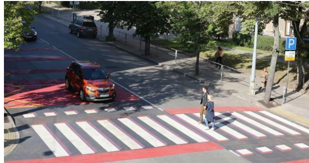
78 pav. Trimatis pėsčiųjų perėjos įrengimas (Lietuva)
