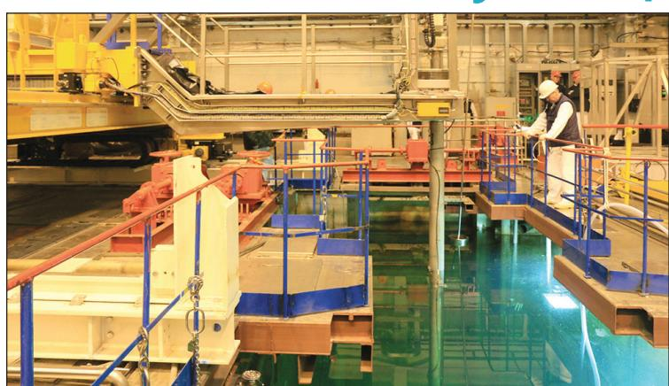
С лета 2020 г. до декабря 2022 г. на ИАЭС был выполнен проект «Очистка дна бассейнов выдержки топлива», который включал в себя очистку дна бассейнов выдержки топлива от фрагментов ядерного топлива (иначе называемых – просыпей топлива) с использованием специально установленного оборудования.
